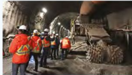
Visite du chantier du garage Côte-Vertu de la STM organisée par le comité régional de Montréal
