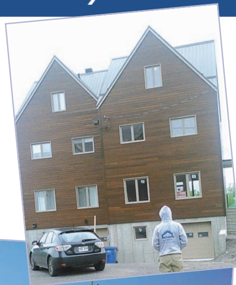
Toiture et revêtement extérieur de condos au Saguenay
