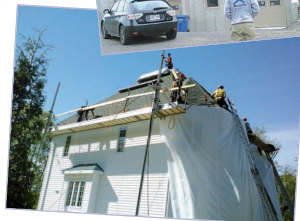
Restauration de toiture, rue des Peupliers, Tadoussac.
