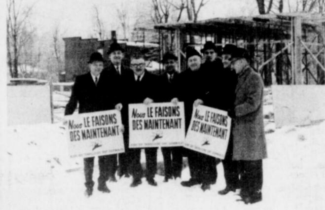
A Longueuil, on profite des mois d'hiver pour effectuer des travaux d'agrandissement de l'usine de filtration. Ces travaux sont exécutés par Community Entreprises. Le maire, des échevins, des officiers municipaux et des représentants de la compagnie apparaissent sur cette photo.
