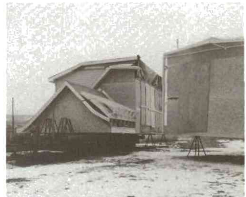
Maisons modulaires: sections de maisons dont les toitures sont repliées afin de réduire le volume excé- dentaire lors du transport.
