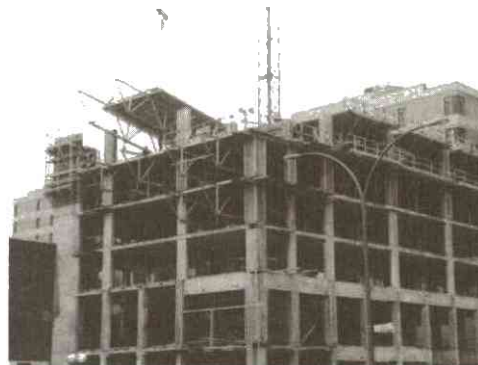
Industrialisation du chantier: plateforme de coffrage réutilisable pour la fabrication de dalles de plancher en béton.
