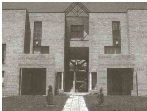
Logements en copropriété au centre-ville de Montréal utilisant la technologie de construction par modules.
