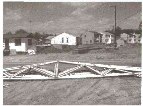
Industrialisation du chantier : fermes de toit préfabriquées.
