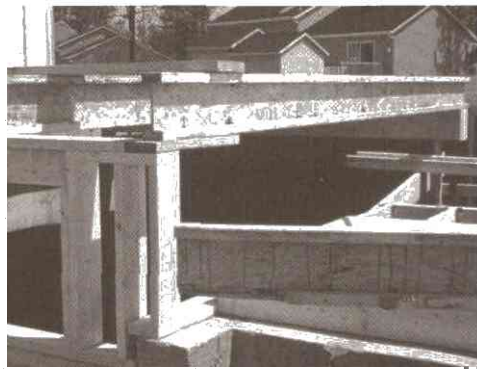
Industrialisation du chantier : solives préfabriquées utilisant des planches de bois gaufré.
