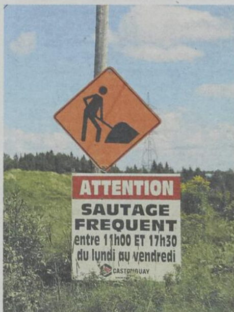
Les travaux sont en cours pour réaliser le tronçon de la 73 à Beauceville.
