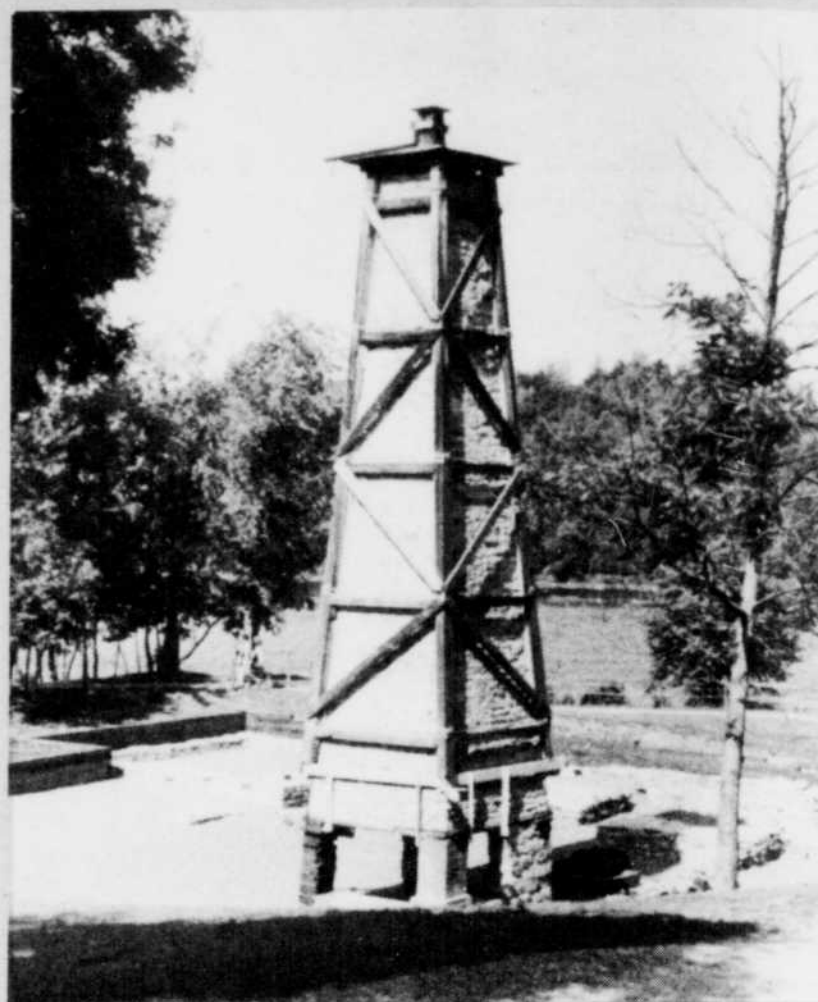
La grande cheminée raconte déjà une partie de l'histoire des Forges du st-Maurice. On est maintenant à reconstruire le haut-fourneau pour donner à l'ensemble une cohésion historique encore plus grande.
