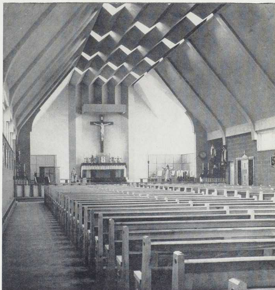
Vers l'autel. Des projecteurs sont dissimulés dans les nervures de la voûte.
