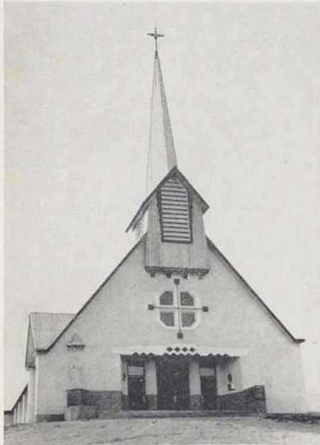
La façade. A droite, l'ensemble. Ligne simple, silhouette traditionnelle.
