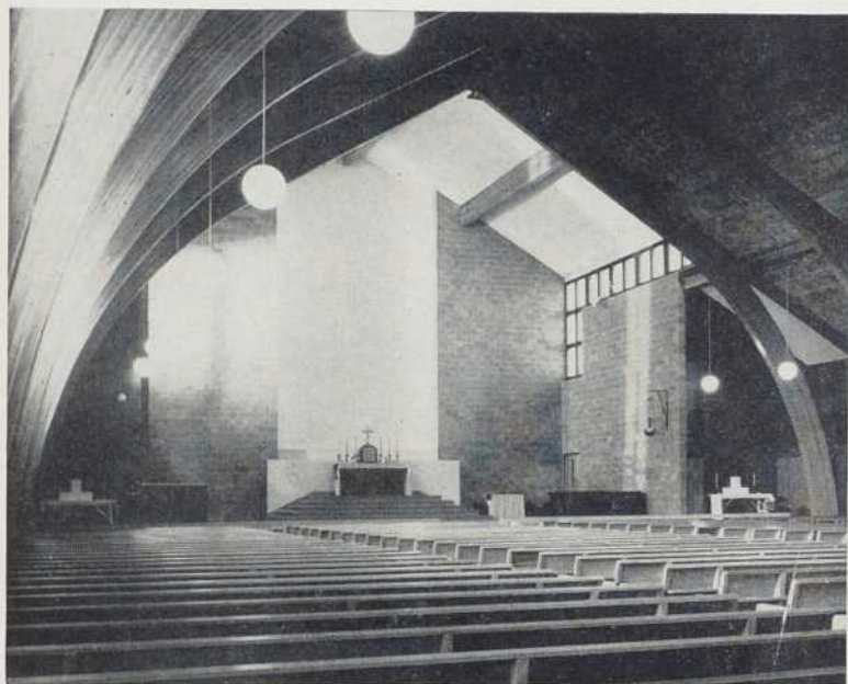
Vue vers l'autel. Une composition structurale différente dégage bien le chœur.
