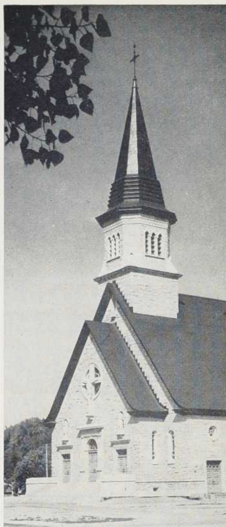
Détail des toits du vestibule et de la nef.
