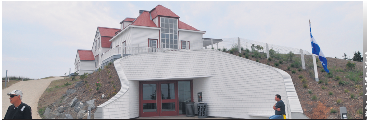
Un rez-de-jardin a été construit pour l'entrée des visiteurs.
