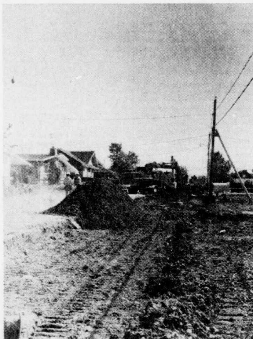
Les travaux sont commencés sur la route 269 à Pontbriand.
