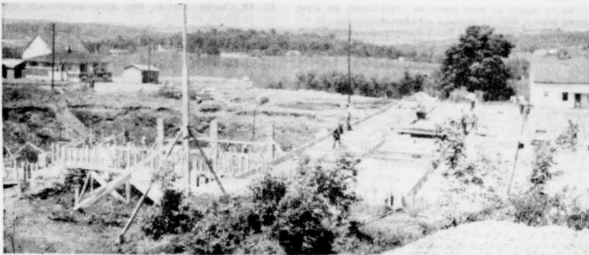
Bonne allure des travaux. — Les travaux de la construction de l'école des Métiers d'Asbestos progressent à bonne allure depuis que la grève des ouvriers de la construction est terminée. Une bonne partie des fondations, à droite sur la photo, est presque terminée tandis qu'on
