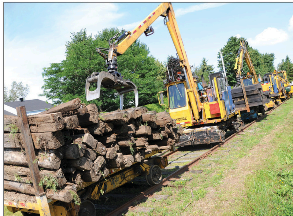
Ces travaux d'envergure se poursuivront jusqu'à la fin de l'année
