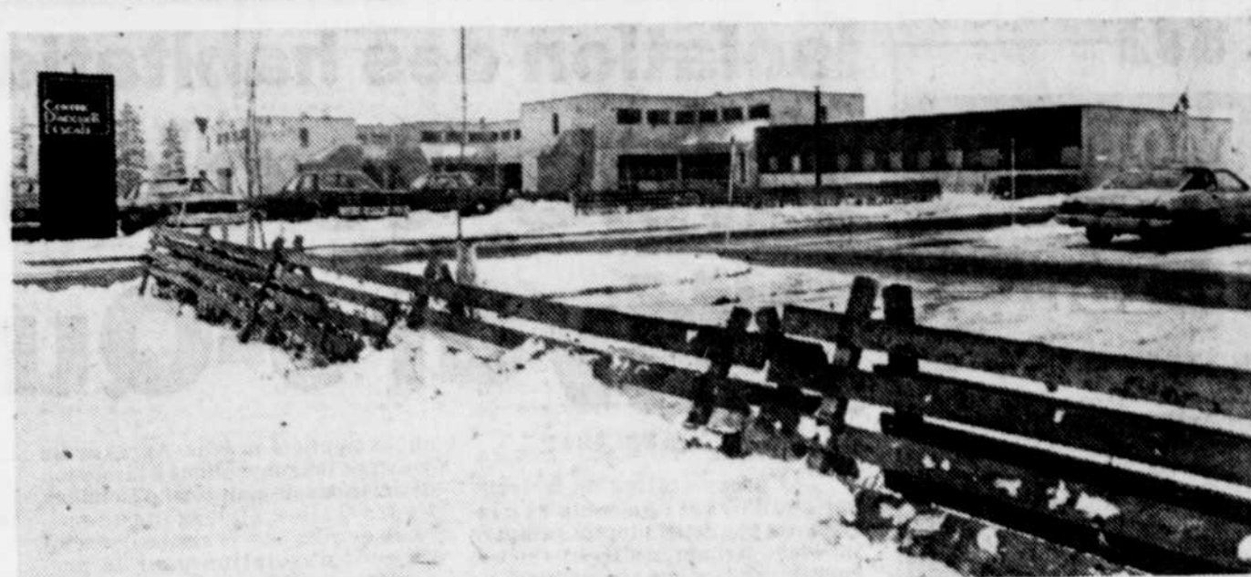
Le centre d'accueil L'Escal, à Cap-Rouge, un internat pour adolescentes en difficultés.
