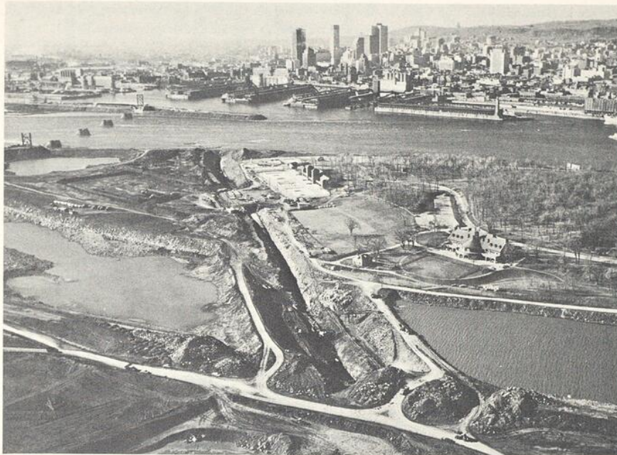
État des travaux en novembre 1964 sur les îles Notre-Dame (à l'avant plan) et Sainte-Hélène (au milieu). Les deux îles sont reliées par un remblai qui retient les eaux pendant la construction du métro prolongé jusqu'à la rive sud. Une fois terminées les deux îles seront séparées par les eaux et reliées entre elles par un pont.
