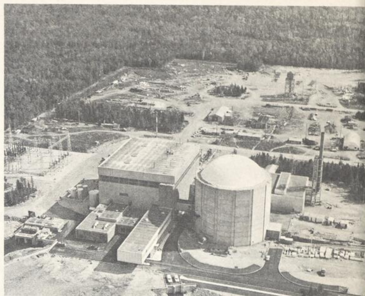
STATION NUCLÉAIRE DE DOUGLAS POINT (CANDU). Cette centrale de 200 MWé est la première au Canada à fournir à grande échelle du courant électrique produit à l'aide de l'énergie nucléaire. Le bâtiment circulaire coiffé d'un dôme d'acier de 130 pieds de diamètre abrite le réacteur nucléaire qui libère une puissance thermique de 693 MWt.
