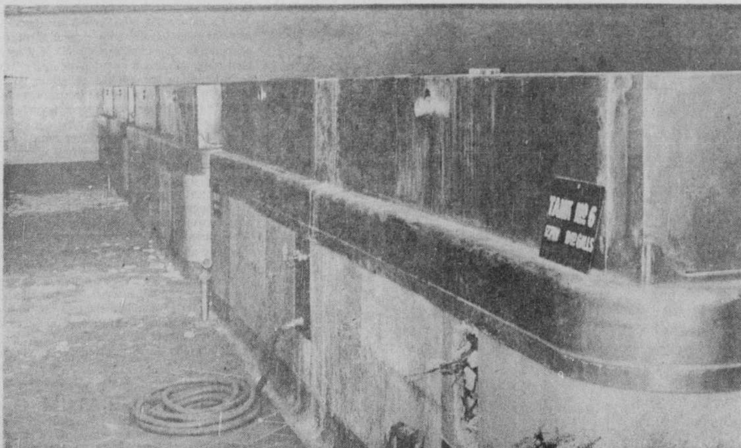
Quelques 270 cuves et réservoirs de bois et de métal, ayant une capacité allant jusqu'à 30,000 gallons, disparaîtront avec la démolition des installations.
