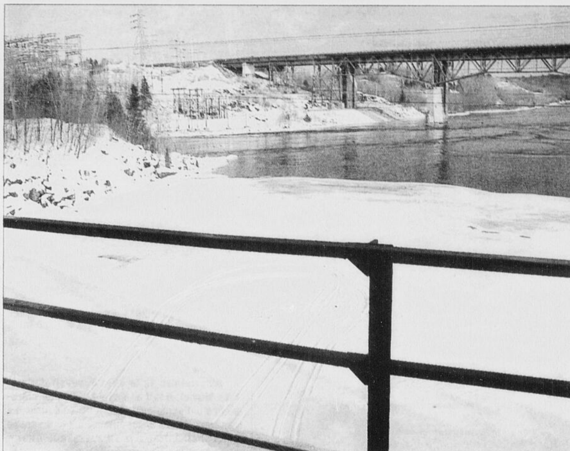
Au cours des derniers jours, des motoneigistes se sont aventurés dangereusement près du barrage d'Isle-Maligne, à Alma. Des trous pour la pêche blanche ont même été creusés sous le pont de la centrale hydroélectrique.
