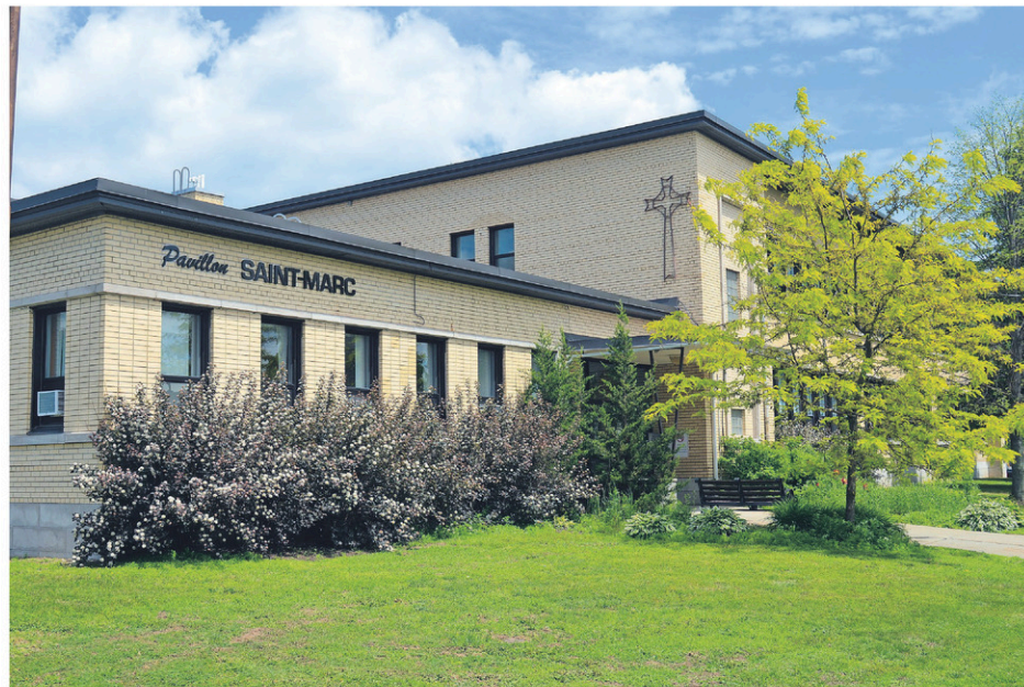
Val-des-Cerfs procédera à l'installation de quatre unités modulaires au pavillon Saint-Marc de l'école primaire L'Étincelle, de Granby, durant la période estivale.
