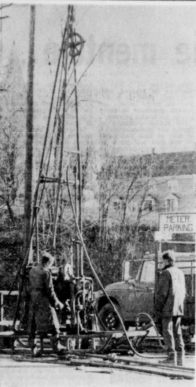
Des sondages de terrain sont présentement effectués sur le stationnement de la ville de Rock Island, rue Principale pour l'érection d'un bureau de douane. C'est la firme Laboratoires Sherman de Sherbrooke qui effectue ces travaux. Les sondages sont effectués sur une distance de 250 pieds entre la rivière Tomifobia et la rue Principale. On aperçoit ci-dessus les employés de cette firme qui exécutent les travaux de sondage.
