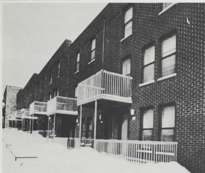
Habitations Larivière. Architecte: Laurent Calame, Projets et chantiers, Service de l'habitation
