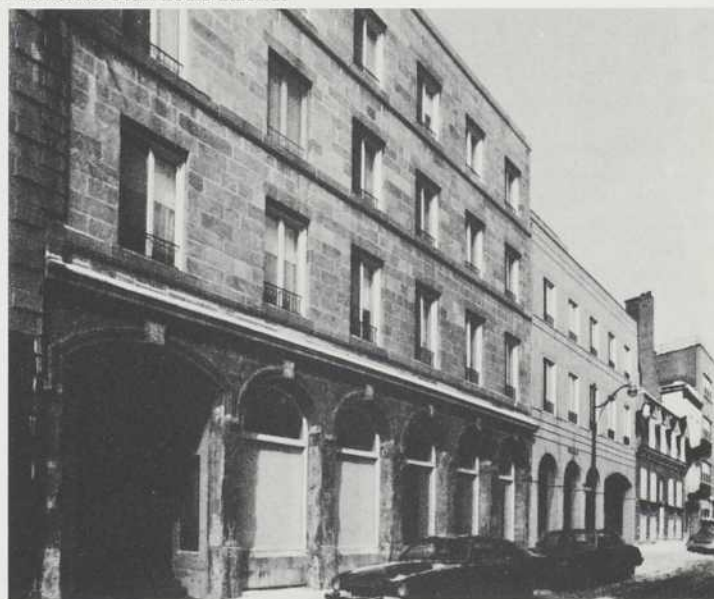
Habitations Dollier-de-Casson. Architecte: Laurent Calame, Projets et chantiers, Service de l'habitation
