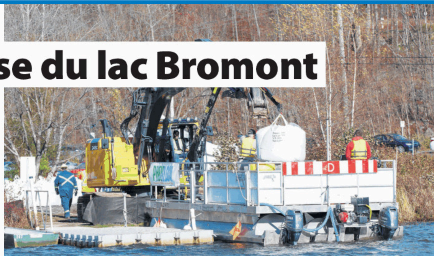
Une barge est utilisée pour pomper l'eau du lac, à laquelle est dilué le Phoslock. L'eau laiteuse ainsi conçue est ensuite distribuée à la surface du lac. Cette substance se déposera sur les sédiments au fond du cours d'eau dans les 24 heures suivant son application. (Photo: TC Media - Nicolas Racine)
