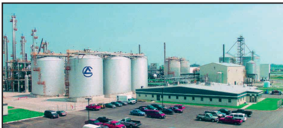
Usine d'éthanol Commercial Alcohols Inc. à Chatam, Ontario
