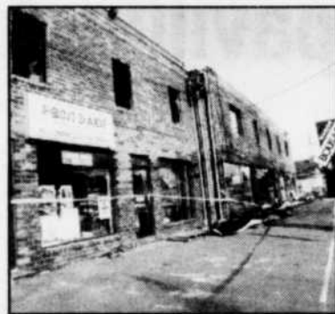
Un périmètre de sécurité a été dressé tout autour de l'édifice incendié.
