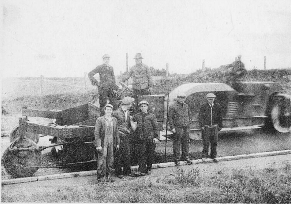
On aperçoit sur cette photographie un groupe de travailleurs de Scott lors du premier asphaltage de la route 23.
