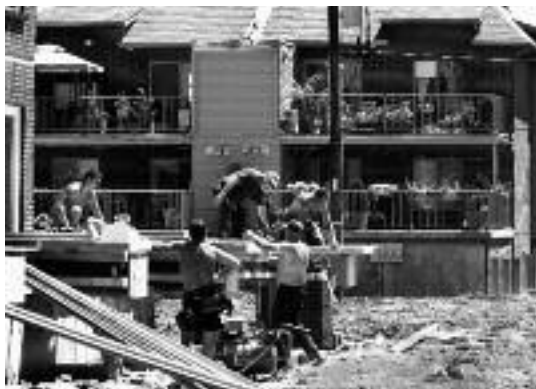
Chantier de construction à Montréal
