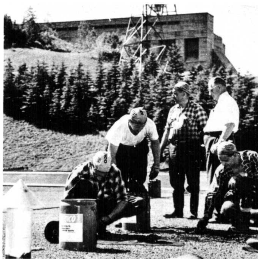
SOUPIRAUX EN ALUMINIUM — Les employés du service de la mécanique viennent de compléter l'installation de 90 soupiraux en aluminium sur le toit de la centrale hydroélectrique de Shipshaw. Quatre employés du service de la mécanique, MM. Lévis Villeneuve, Larry Chambers, Steven Côté et Robert Villeneuve complètent ici leur travail, sous les yeux du Surintendant des usines de Shipshaw et de Chute-à-Caron, M. Bert Bourget.
