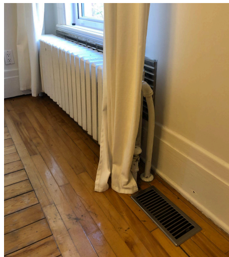
Radiateur à eau chaude et sortie de plancher (air chaud ou froid)
