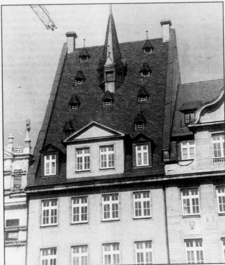
Reconstruction sur la place du vieux marché de Leipzig avec, dans le ciel, l'omniprésence d'une grue mécanique. Elles étaient 800 lors du démantèlement du mur de Berlin! photos Monique Nuytemans
