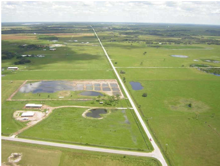
Figure 3.8 Vue aérienne du site d'échantillonnage de 5 000 m (vue en direction est)
