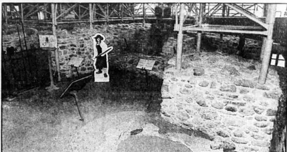
Le centre d'interprétation abrite les vestiges du haut fourneau. Les structures métalliques restituent la silhouette des anciennes bâtisses.
