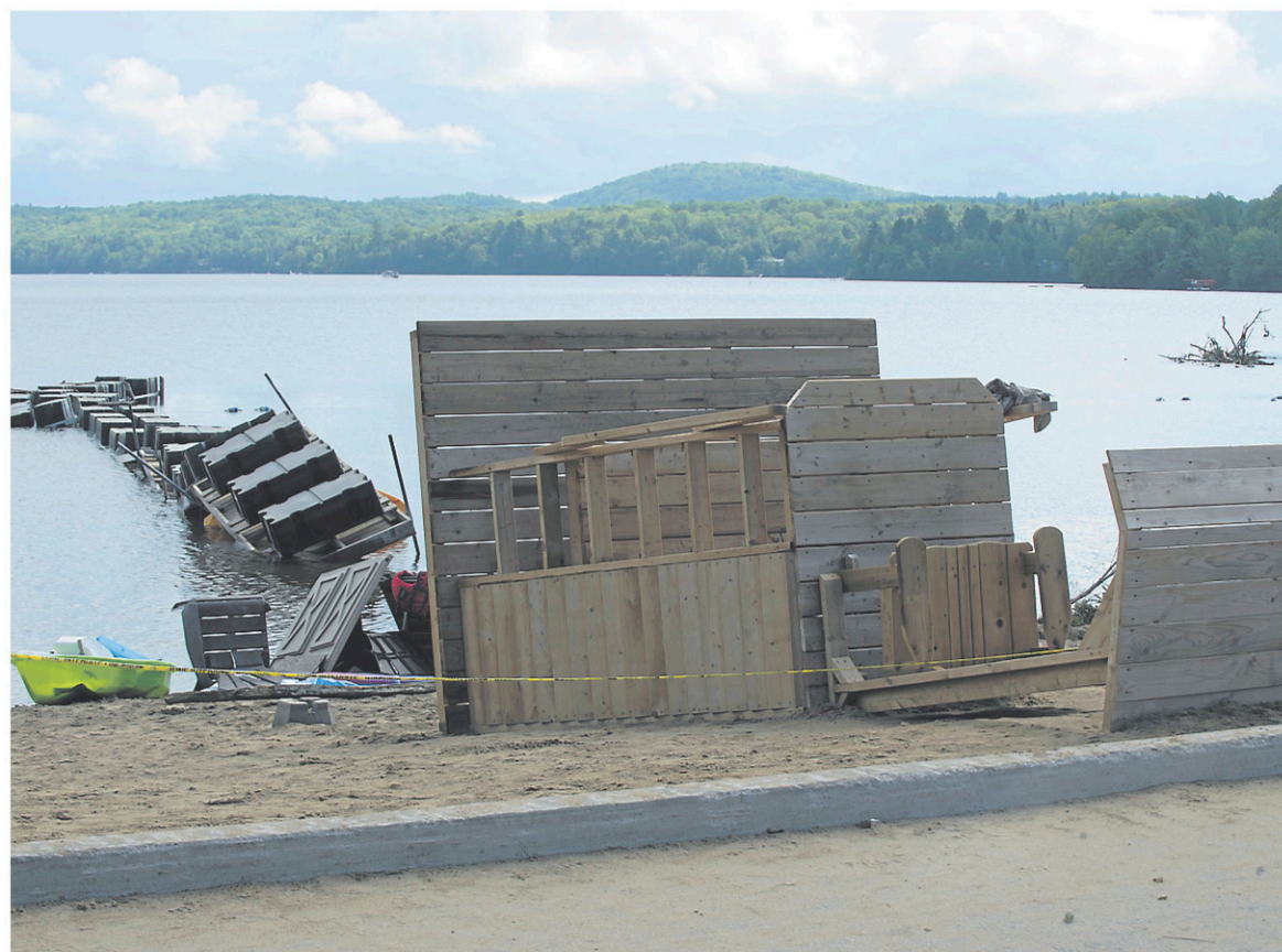
Le quai du camping s'est retourné sous la force du vent. — PHOTO: SYLVAIN MAYER
