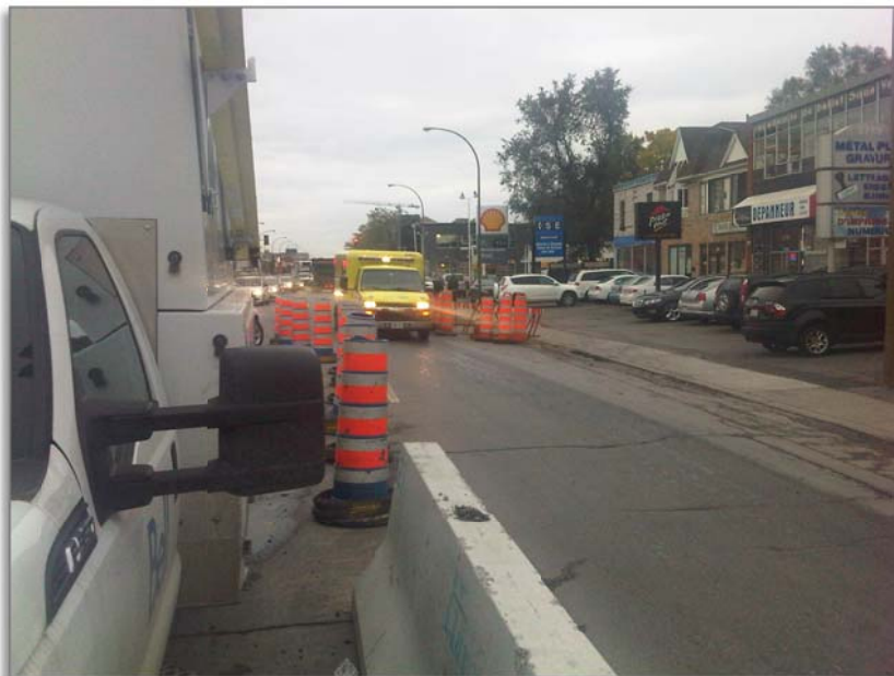
Figure 22 : Engagement d'un véhicule ambulancier à contre sens lors des travaux de remise en état sur la rue Jean Talon
