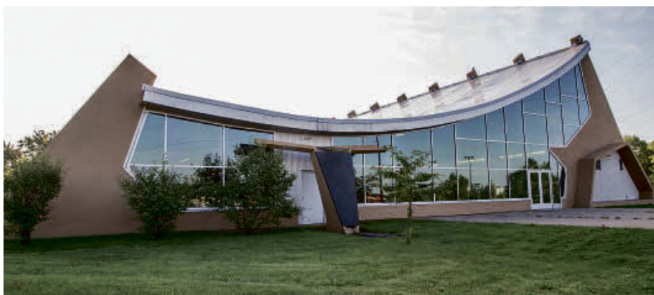
La Ville rénovera l'enveloppe extérieure de la piscine Laurier-R.-Ménard en attendant la construction d'un nouveau centre multisport. (Photo: Pascal Cournoyer)
