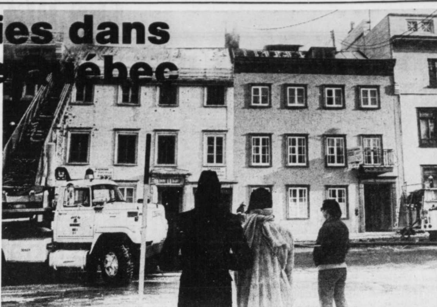
Deux immeubles adjacents des rues d'Auteuil et Sainte-Ursule ont été lourdement endommagés par le feu, tôt samedi.
