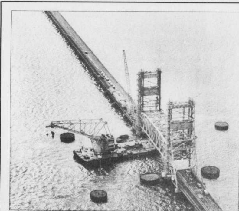
Des ouvriers s'affairent à réparer le pont-levis de Valleyfield
