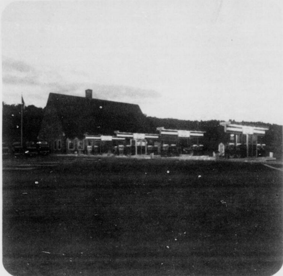
Pouvant alimenter en carburant jusqu'à 16 véhicules à la fois, le poste de service offre aussi aux automobilistes tous les services de dépannage, de mécanique et de pièces automobiles.
