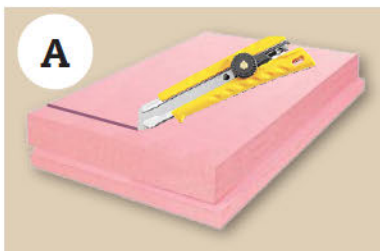
A) Couper des panneaux d'isolant aux mesures intérieures des bacs.
