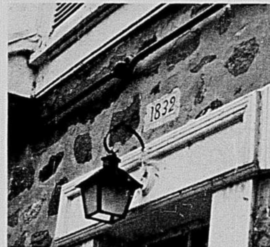
Cette maçonnerie de pierres datant de 1832, il a fallu la ceinturer pour l'empêcher de s'éventrer.
