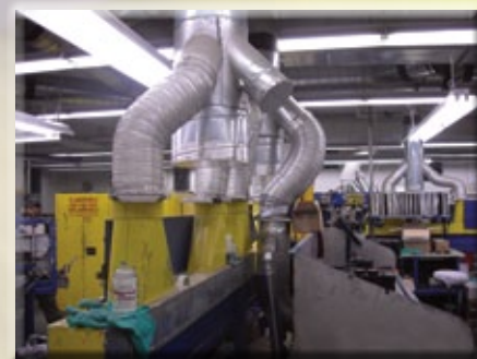
Les conduits du système d'aspiration de l'air.
