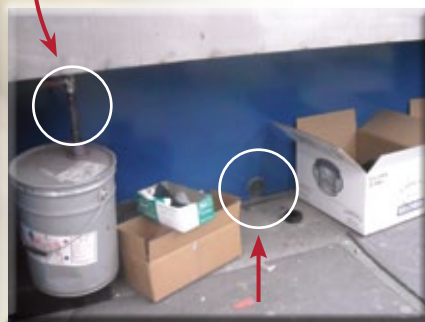
Sous la table de travail, on a ajouté un deuxième conduit d'aspiration.
