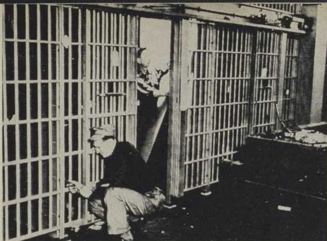
DES OUVRIERS D'EXPERIENCE ASSEMBLENT LES CELLULES PREFABRIQUEES A L'USINE ELLE-MEME, AFIN D'ASSURER LA PLUS GRANDE SECURITE QUAND ELLES SERONT INSTALLEES A LA PRISON.
