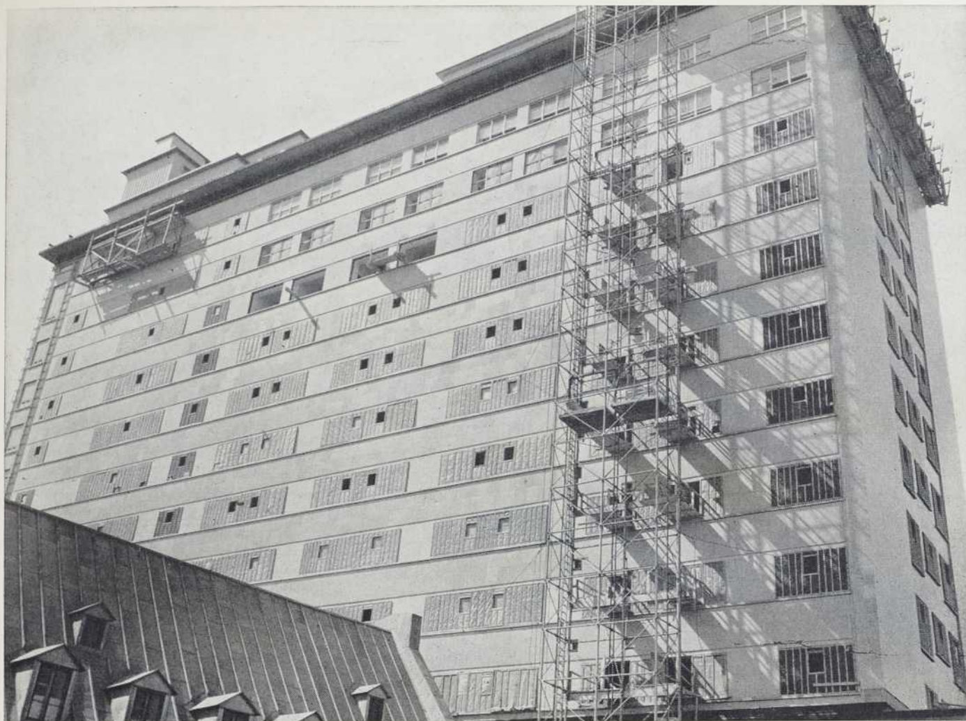
LE NOUVEAU PAVILLON DE 14 ÉTAGES de l'Hôtel-Dieu, à Québec. La mousse isolante STYROFOAM a été appliquée directement aux murs de maçonnerie, le plâtre étant ensuite appliqué directement sur l'isolant, sans l'usage de fourrure ni de lattes.
