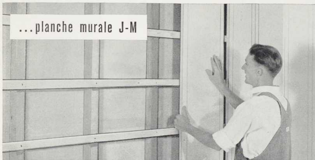
Fini Glazecoat. Les panneaux pour plafonds et la planche murale ont tous deux un fini résistant aux flammes, facile à nettoyer.
