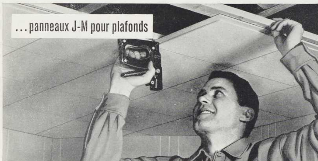
Joint éclair à 3 plans. Caractéristique J-M, masque clous ou agrafes, renforce, assure un alignement rapide.
