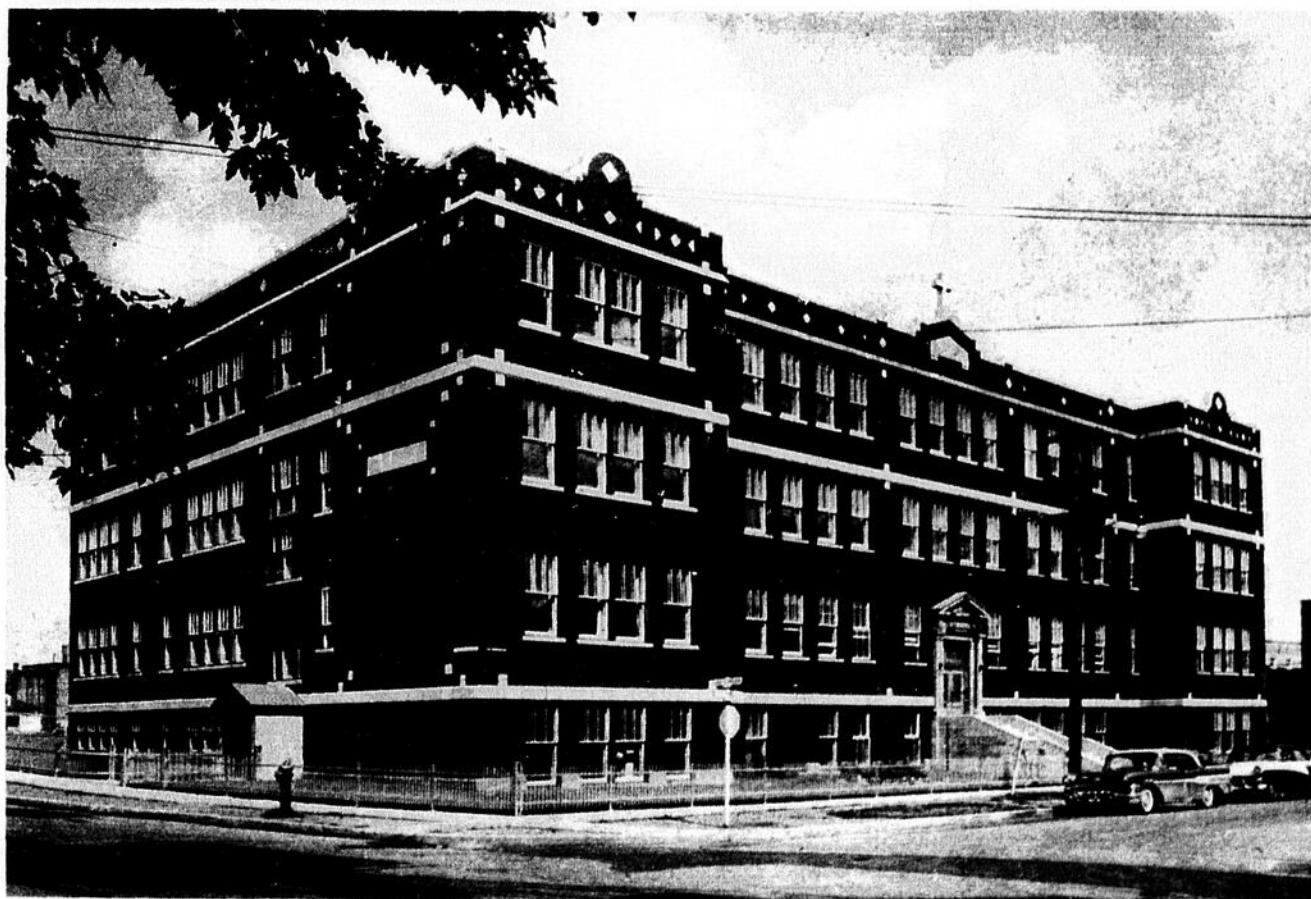
En 1934, la Commission scolaire décida d'aménager un troisième étage à l'école Sacré-Coeur, pour y faciliter l'accès
