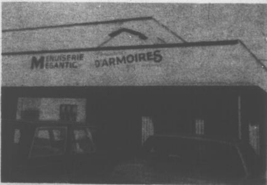
Installations de Menuiserie Mégantic, rue Québec Central.
