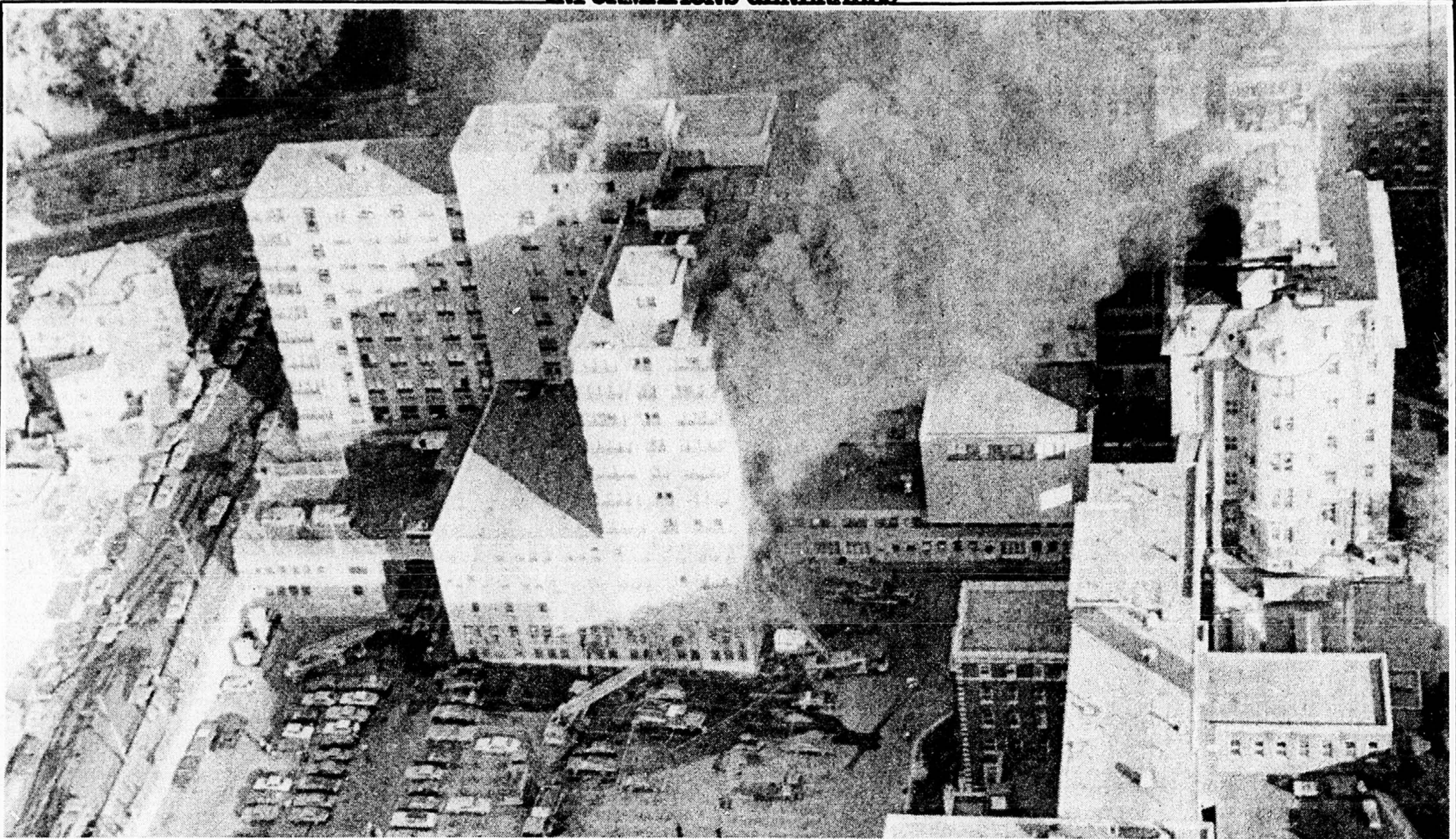
Vue aérienne du pavillon Lachapelle, vers 7h, hier matin
