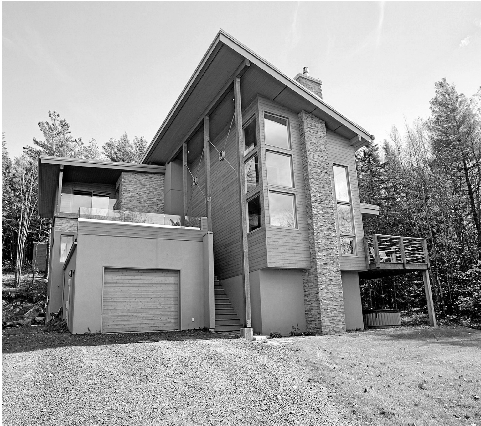
PHOTOS FOURNIES PAR ÉQUIPE LACROIX Bien que contemporaine, l'architecture de la maison n'est ni stricte ni froide, grâce à des jeux de formes et des mariages de matériaux différents. La fonctionnalité est de mise, à commencer par les cinq garages fermés donnant directement accès à l'intérieur.
