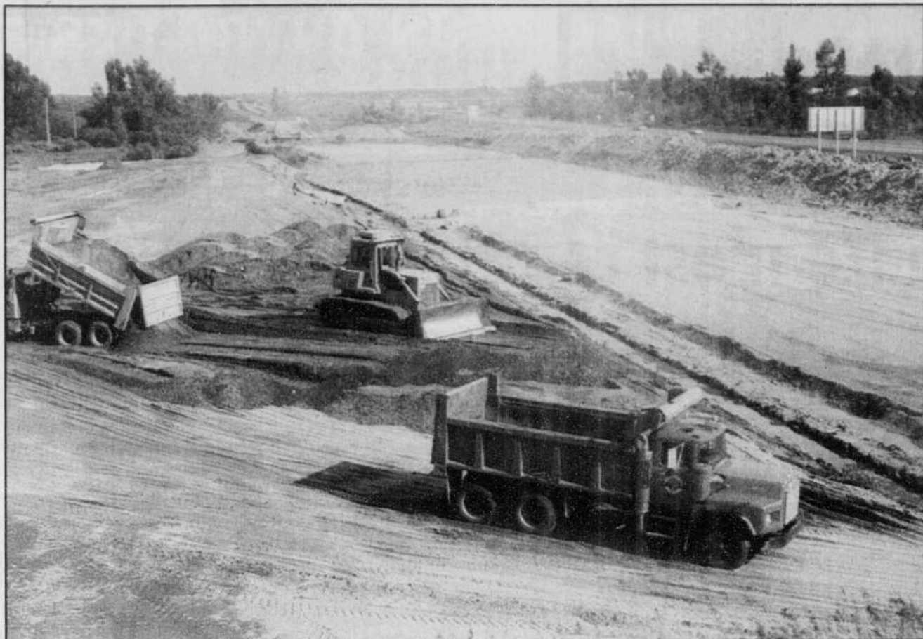
La chaussée en direction est de la nouvelle section double de l'autoroute 55, entre la 20 et le boulevard Jean-de-Brébeuf, devrait être accessible à la circulation dès la fin du mois d'août de l'an 2000.
