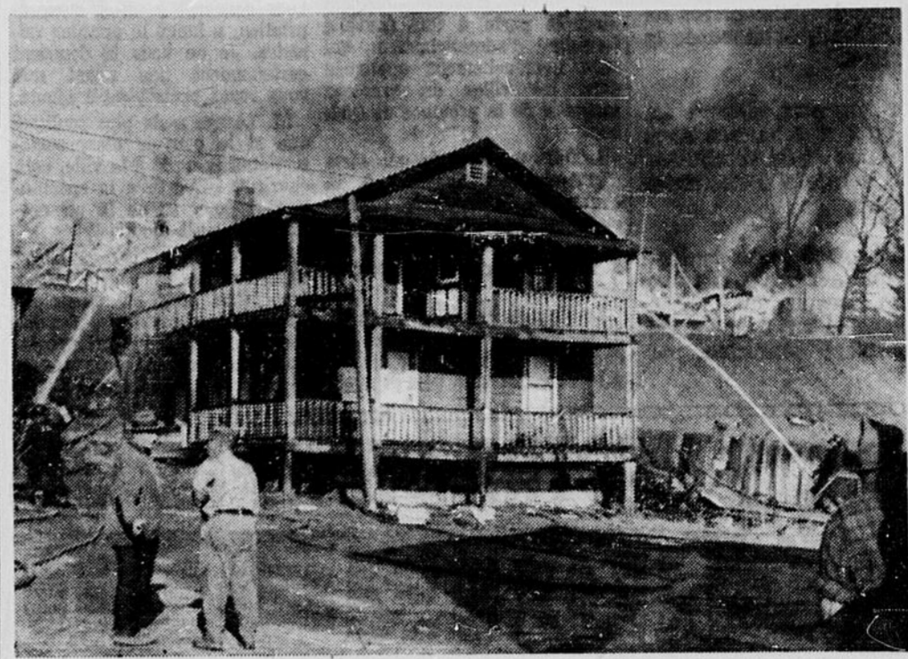
UN DES TROIS IMMEUBLES EPARGNE — Les pompiers volontaires de Maniwaki n'ont pu préserver des flammes qu'un seul des trois immeubles à logis, propriétés de Mme Arthur Pelletier, alors qu'un violent incendie a rasé au sol mercredi matin les deux autres édifices
