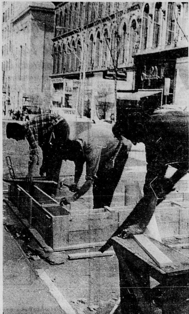
BOITES A FLEURS — La construction des boîtes à fleurs qui enjolivent le mail de la rue Sparks occupe nombre de travailleurs. Trois menuisiers préparent ici les formes de bois qui recevront le ciment pour devenir une boîte à fleurs haute de 24 pouces. (Photo Champlain Marcil)
