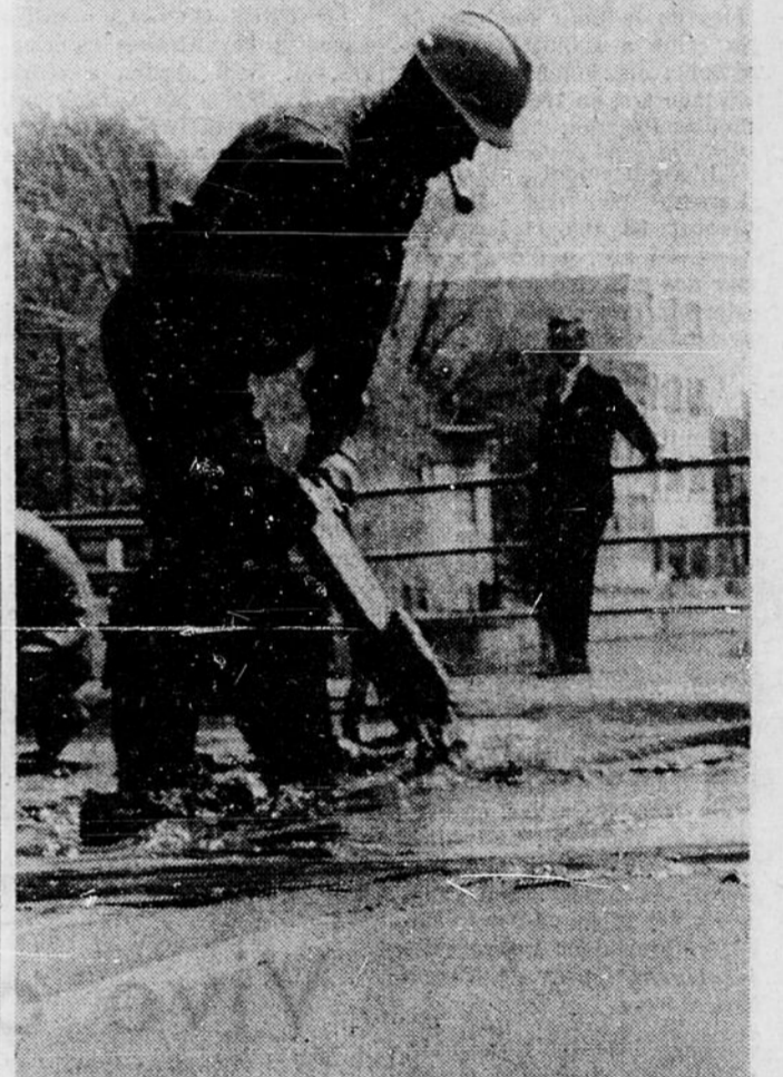
BRIS DE LA CONDUITE PRINCIPALE D'EAU A HULL — Pour une durée d'un peu plus de six heures, les trois cinquièmes de la population de Hull n'ont pu bénéficier, mercredi après-midi, des services normaux de l'eau potable. Un segment de la conduite principale, sur la rue Montcalm, a cédé à la pression trop forte, permettant ainsi à l'eau de s'en échapper et de se frayer un chemin jusqu'au pavage, le boursoufflant à plusieurs endroits comme le montre cette photo. Pour de plus amples détails, voir l'article en page de Hull.
