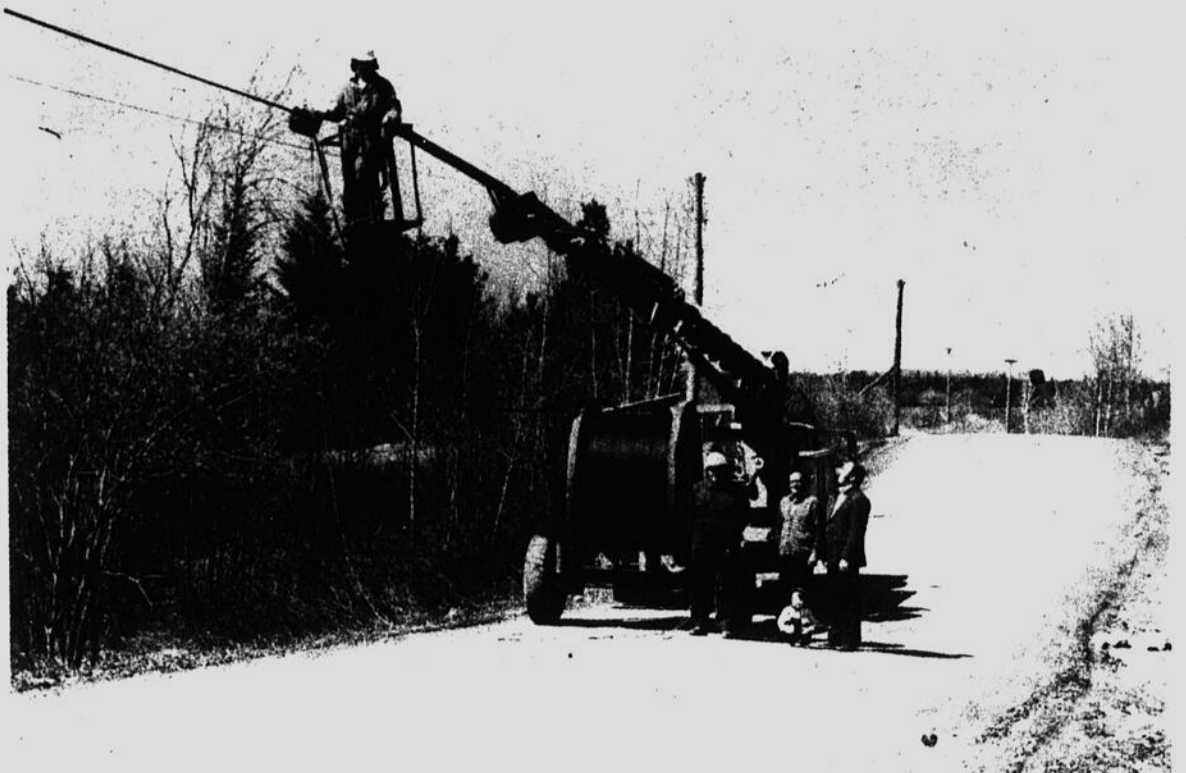
A LA CIE DE TELEPHONE DE LAMBTION: Cette photo a été prise dans le rang St-Michel où "Les lignes Kennebec Inc." procède à la pose du câble; une partie des 128,000 pieds posés depuis décembre dernier. Nous apercevons sur la photo le président de la compagnie de Téléphone de Lambton Inc. M. Renaud Letarte et un directeur M. Armand Baillargeon, du président de "Les Lignes Kennebec Inc." M. Simon Champagne et M. Jean-Louis Mathieu, monteur de lignes, tous deux de Beauceville. Ajoutons que Manon Letarte a voulu elle aussi se rendre compte des travaux exécutés...
