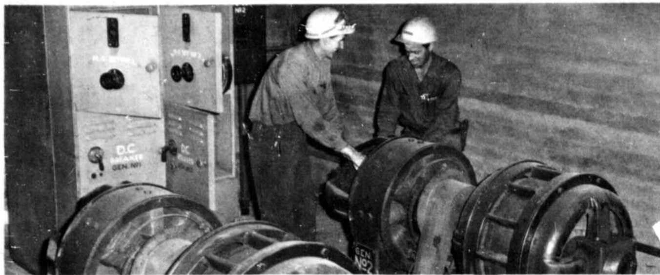
"ILS SE SONT TUS" — Pendant vingt-trois ans, ces unités de génération de courant continu ont alimenté les moteurs des ponts-roulants. Maintenant remplacés par un redresseur au silicium, il ne reste qu'à les mettre au rancart. Ce que font M. Thomas-Louis Maltais, à gauche, et M. René Hudon, tous deux de l'équipe de la construction.
