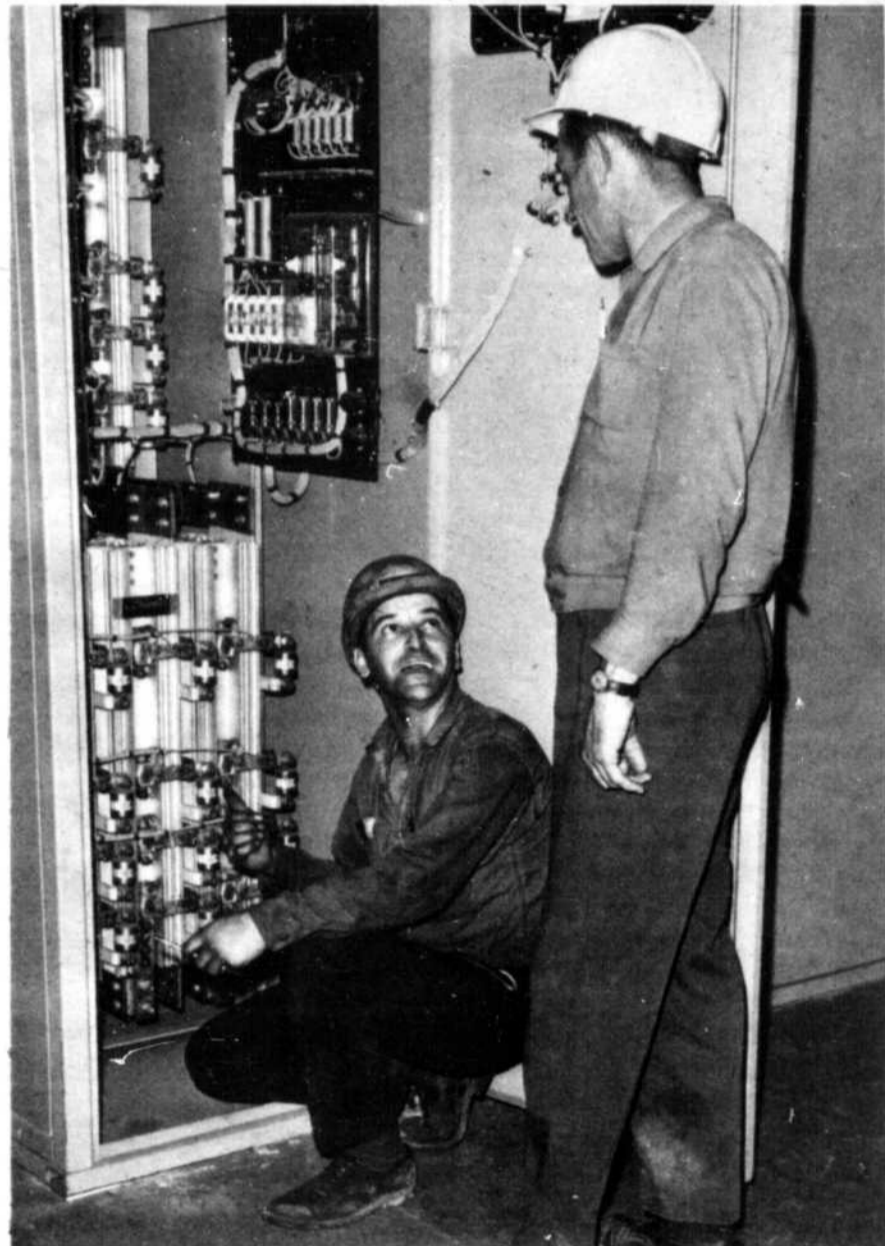
L'INSPECTION PERIODIQUE — Cette nouvelle unité de redressement de l'électricité au silicium ne comprend pas de points d'usure; il suffira d'y jeter un coup d'oeil tous les mois; c'est ce que fait M. Roch Lavoie, de l'équipe d'entretien du contremaître M. Jean-Marie Potvin. Le contremaître de l'équipe de construction, M. Joseph-Henri Potvin, vient jeter un dernier coup d'oeil à cette installation complétée par ses hommes.
