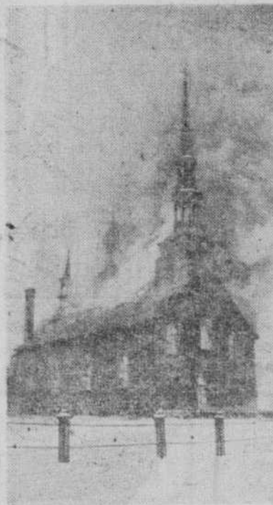
Ancienne église, incendiée le 25 décembre 1920.
