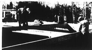
Après que votre fondation a été bien montée, Nos éracteurs s'apprêtent à faire le charpente du plancher. Aucun soliveau ne touche à la fondation ce qui vous assure d'avoir des planchers toujours solides. Nos soliveaux sont des pièces de 2" x 10" au lieu de pièces de 2" x 8" de même que le contreplaqué à 3/4" de pouces d'épaisseur au lieu de 5/8" de pouces. Vous assurez de la qualité "STRUCTOME".
