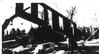
Nos murs sont préassemblés en usine et l'isolation est posée dans des conditions idéales de température évitant ainsi les intempéries qu'entraîne la construction ordinaire. On pose une planche isolante sur les 2 côtés des murs avec les lottages prêts à recevoir les revêtements extérieurs et intérieurs.
