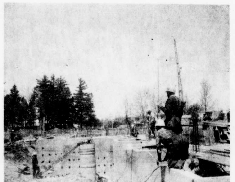
Les travaux de construction de l'Ermitage des Bois-Francis à Victoriaville, vont bon train, et selon toute apparence, devraient être terminés pour la fin de la
