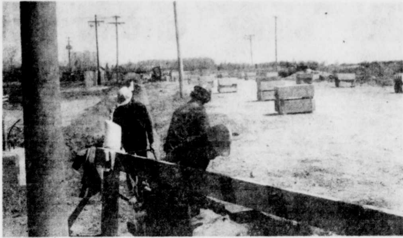
Des employés de Pavage Lasalle Ltée de Drummondville et des sous-traitants s'affairent à compléter les travaux d'aménagement du nouveau tronçon du boulevard Jutras à Victoriaville. Le boulevard est actuellement fermé à la circulation et, selon M. René Mercier, de Pavage Lasalle, le tronçon devrait être ouvert aux automobilistes vers la mi-juillet. (Photo LeRo)
